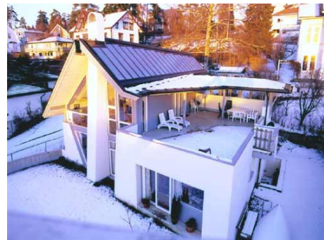
Solfangere på tak av privatbolig i Oslo
